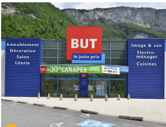
Zone Industrielle de la Maladière à Cluses (74)
